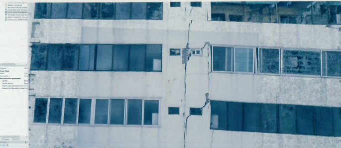
포항 D아파트 안전진단
